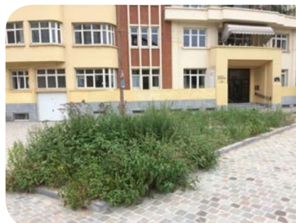
Nouvelle zone de plantation en ville envahie d'adventices
