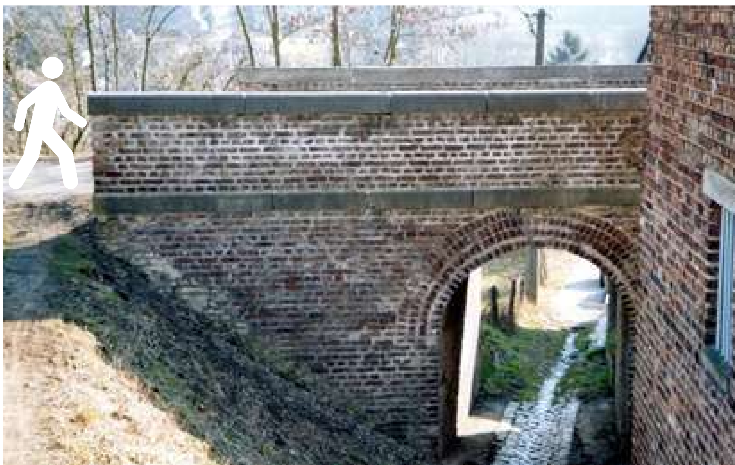
Le tracé du tram passe au-dessus de la ruelle.
